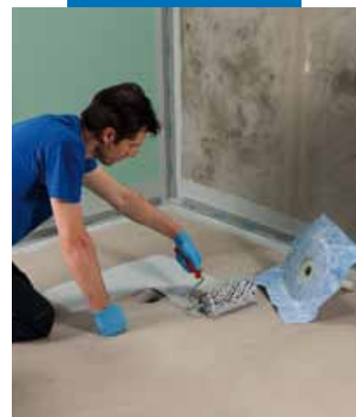
Inštalácia odtokovej vpuste Drain Vertical s použitím Mapegum WPS
