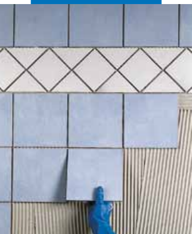
Lepenie jedenkrát pálených obkladačiek na stenu kúpeľne s omietkou
