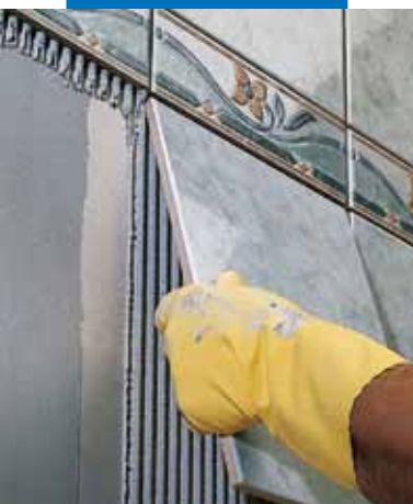
Lepenie jedenkrát pálených obkladačiek na stenu zo sadrokartónu
